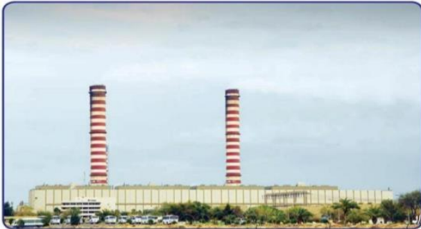
محطة تحلية مياه البحر
